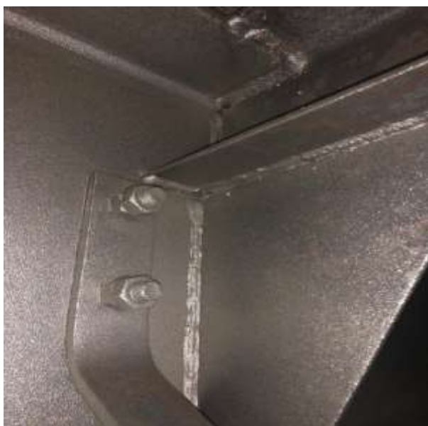
Зона 1 после дробеструйной обработки
