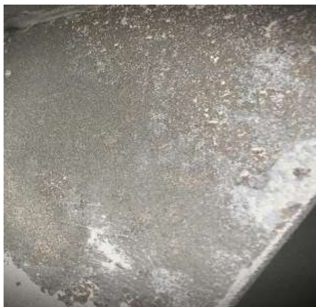
Зона 3 после механической очистки
