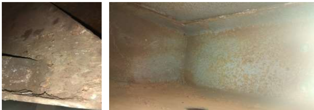
Рисунок 3.11 – Состояние лакокрасочного покрытия вагона модели 61-826
