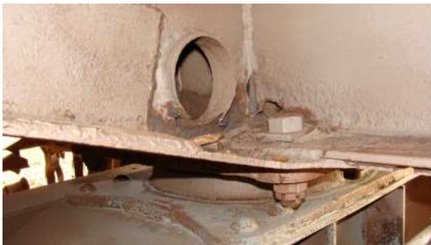
Рисунок 3.7 – Пример наличия сквозной коррозии хребтовой балки вагона модели 61-825
